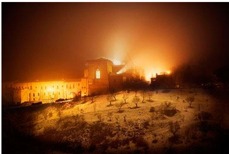
L'Aquila, 17 dicembre 2009, Basilica di Santa Maria di Collemaggio squartata dal terremoto. I lavori di messa in sicurezza e copertura in vista della messa della notte di Natale. © Danilo Balducci, 2009 / Agenzia Sintesi
